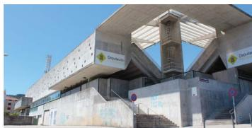
Construido sobre el antiguo campo, este estadio se resuelve con un único elemento, la gran viga-pared de hormigón armado que define su alzado y en el que se apoyan los graderíos.
